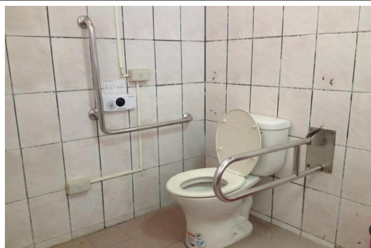
★ 廁所盥洗室加裝扶手設置 ★
